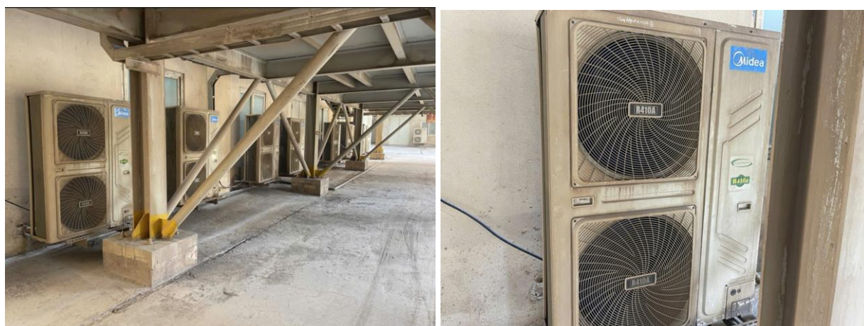
Hình 4.20. Hệ thống điều hòa cục bộ được bố trí tại các khu vực quanh nhà máy
