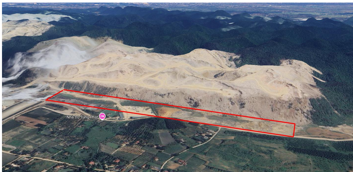
Hình 4.2. Hình ảnh vị trí khu đất khả thi lắp đặt hệ thống điện mặt trời tại Nhà máy Xi măng
