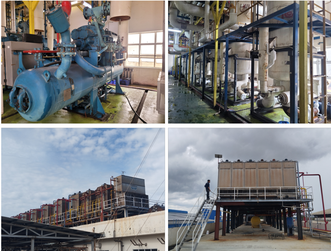
Hình 1.10. Hệ thống máy nén lạnh kiểu trực vít và dàn ngưng tụ
