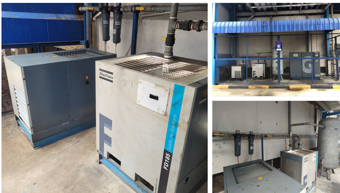
Hình 1.8. Hệ thống khí nén
