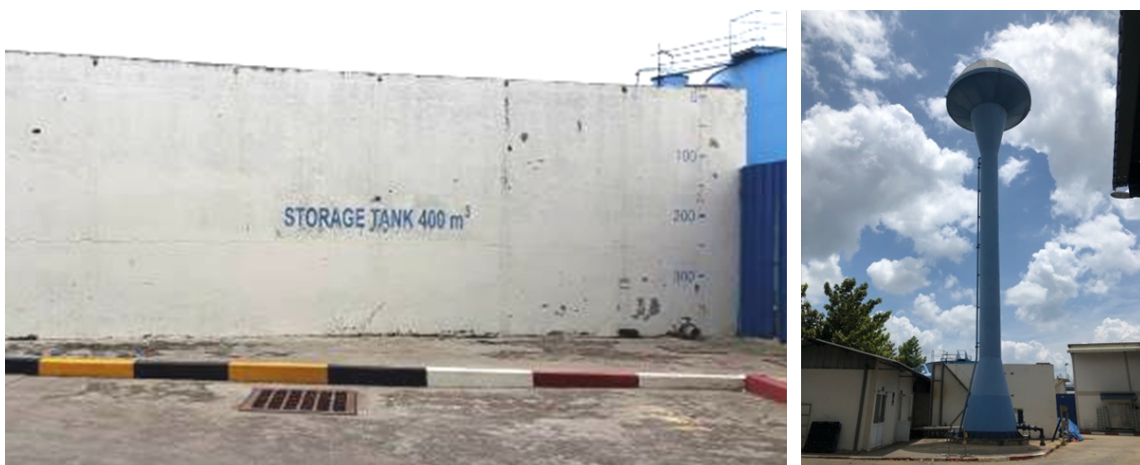
Hình 1.15. Hệ thống bể chứa nước và tháp nước của nhà máy
