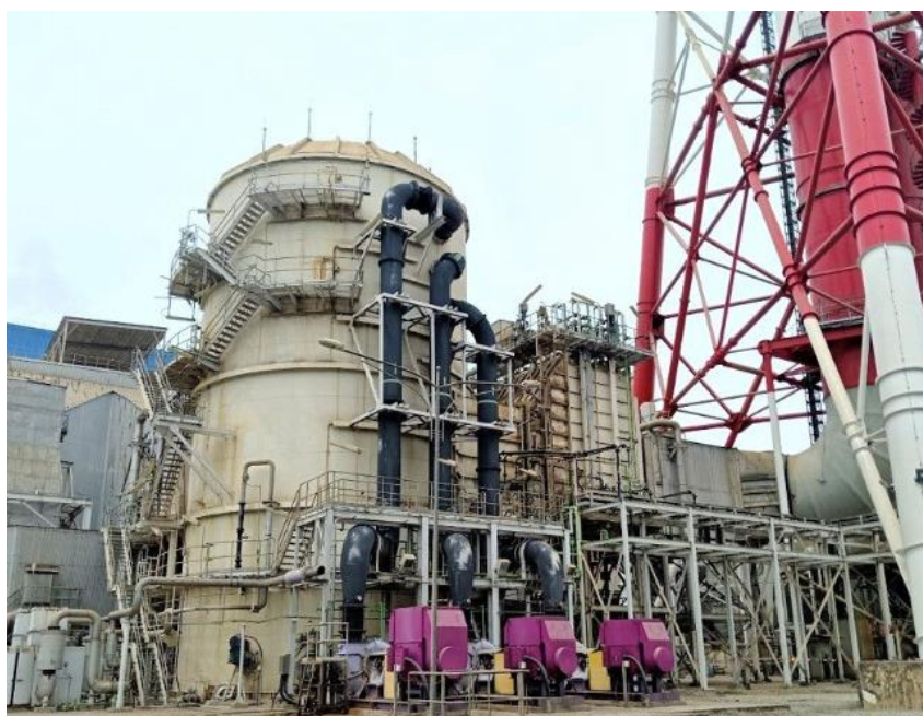
Hình 1.14. Hệ thống xử lý Sox và NOx của Công ty
