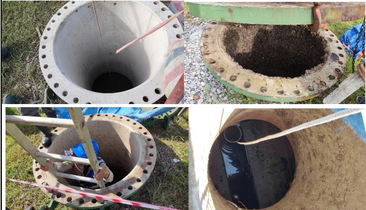
Hình 4.8. Hình ảnh thực tế của các manholes
