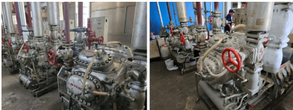
Hình 4.8 Máy nén lạnh pittông
