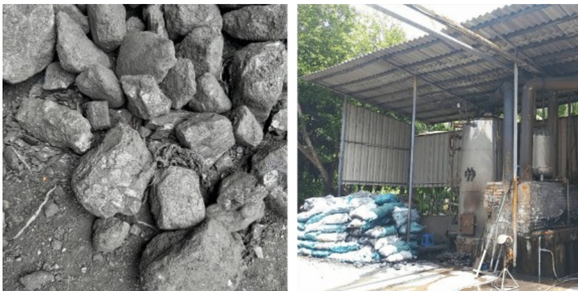
Hình 1.5. Nhà lò hơi tại nhà doanh nghiệp
