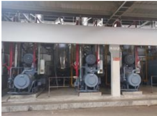
Hình 4.9 Máy nén lạnh trực vít GEA mới được doanh nghiệp đầu tư
