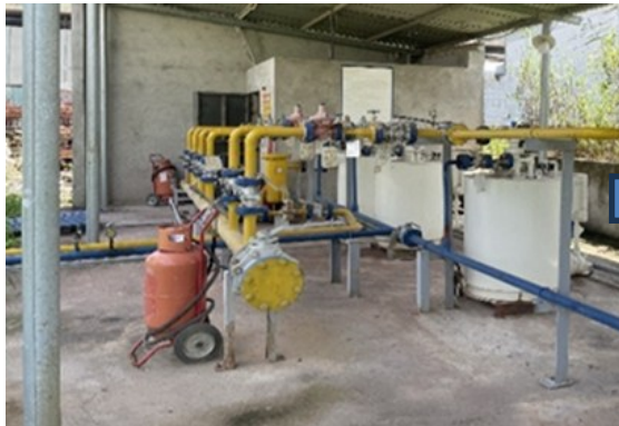
Hình IV.16. Bộ hóa hơi LPG dùng điện
